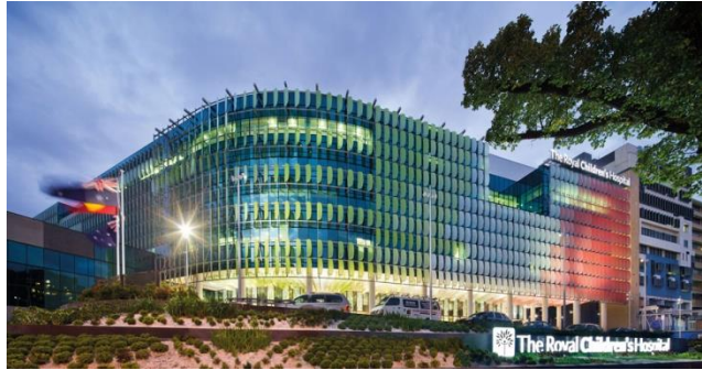
Figure 19 : vue général le Royal Children’s Hospital, Melbourne, Australie
