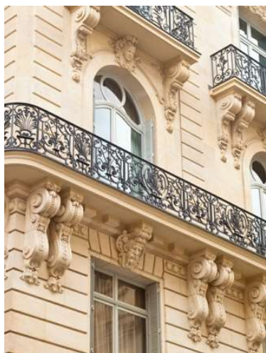
Fig.36 Immeuble haussmannien à Paris
