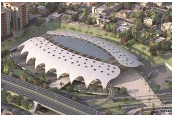
Fig.13 La nouvelle gare routière de Bir Mourad Rais
