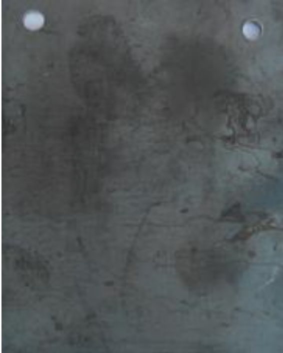
Figure III: 4 Avant préparation de surface
