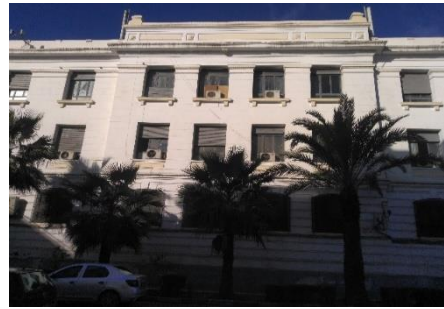
Figure 31 : Département d'architecture d'Alger.
