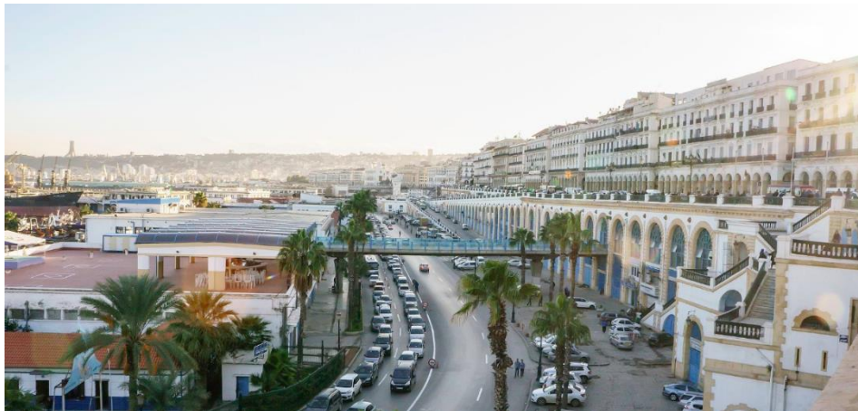
Figure 7 : Façade coloniale, Alger-centre. Source : Site Officiel de la Mairie d'Alger centre.
