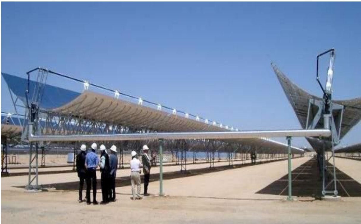
Figure 1.12 : Vue d'une boucle de captage à cylindre-paraboliques de la central Andasol-1. On notera le grand rapport longueur / largeur de la boucle, et les raccords articulés au niveau des absorbeurs. (Solar Millenium)[9]
