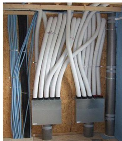
**Figure 49 :** Départ VMC double flux [29]
