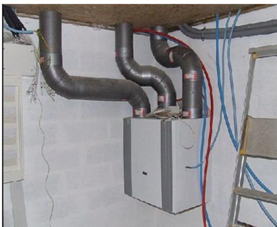
**Figure 48 :** Echangeur VMC [29]
