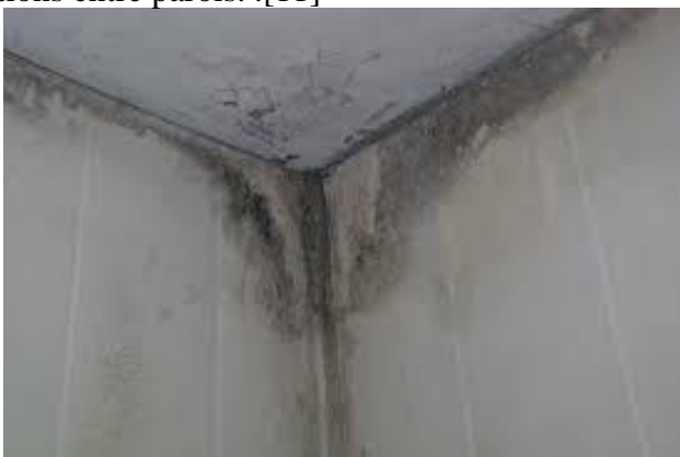
Figure 1-12 :Effet d'un pont thermique ,source systemed.fr/images/conseils/isoler-pont-thermique
