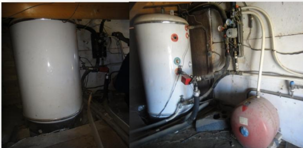
Figure1- 35 : installation de la maison« Soudania- Alger » [26]
