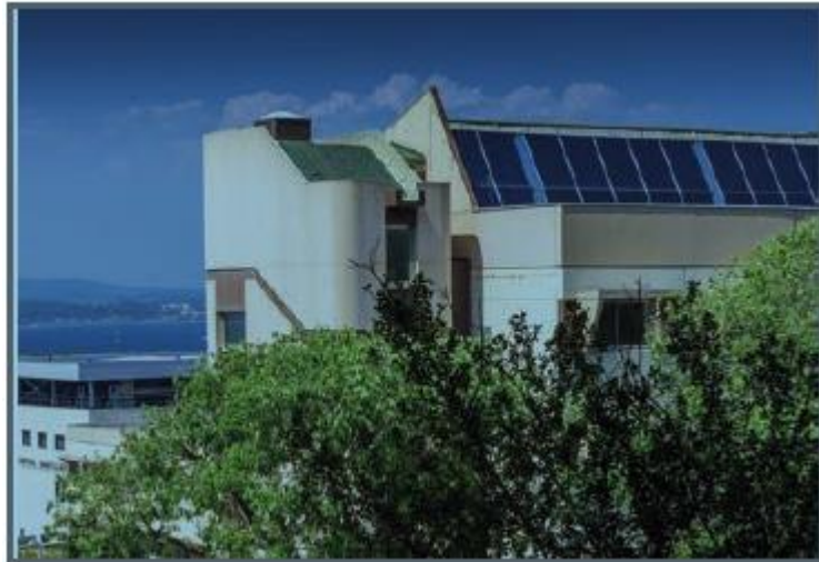
Figure 10 : Les capteurs solaires installés en toiture CH du Bassin de Thau à Sète
