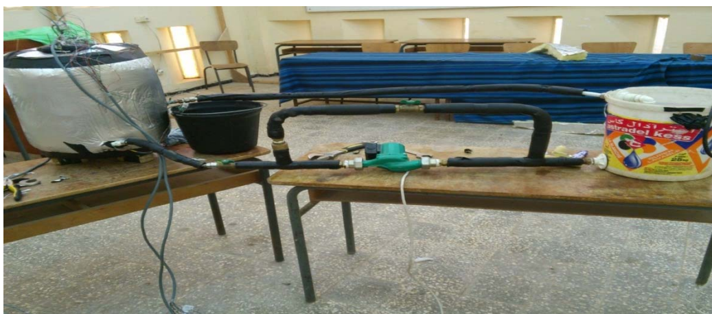
Figure III. 19 : Aperçus sur la cinquième étape du montage.
