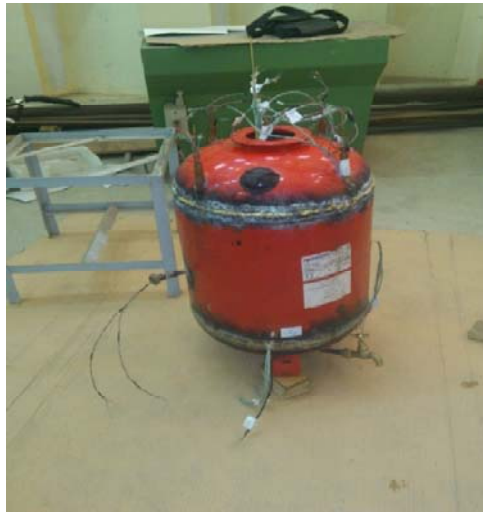
Figure III. 16 : le soudage de la partie haute de la cuve.
