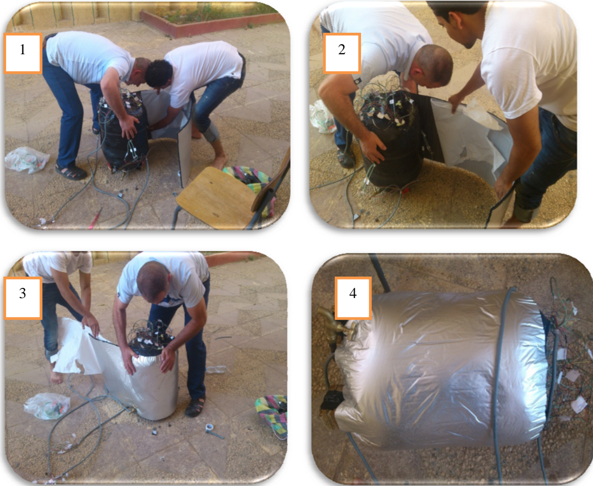
Figure III. 18 : l'isolation avec isoflex.
