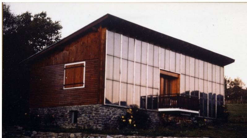
Photo 1-1: prototype de la maison avec mur Trombe du professeur Felix Trombe (1906-1986) à Odeillio, inventeur de ce procédé (photo 1976 de M.Gazeau) [2,4].
