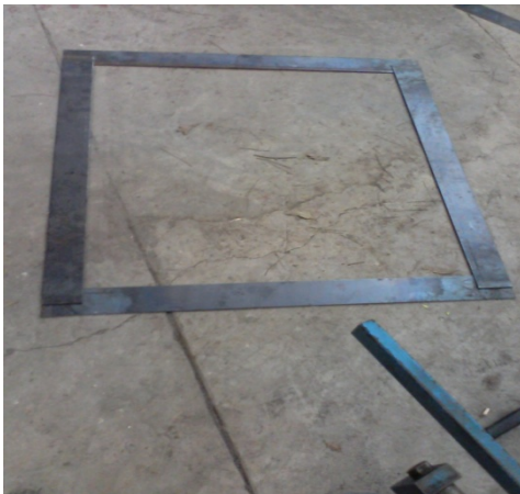
Photo2-2:soudage des plaques
