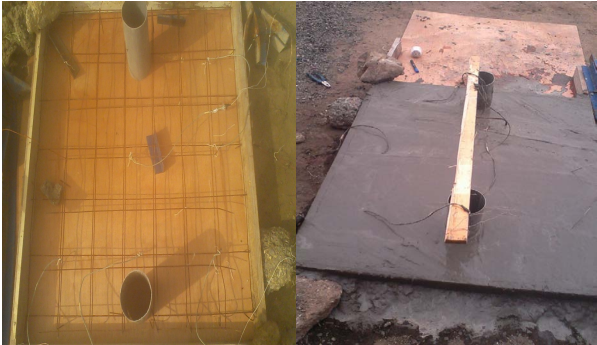
Photo3-14: moule de mur Photo3-15:comble le moule par le béton
