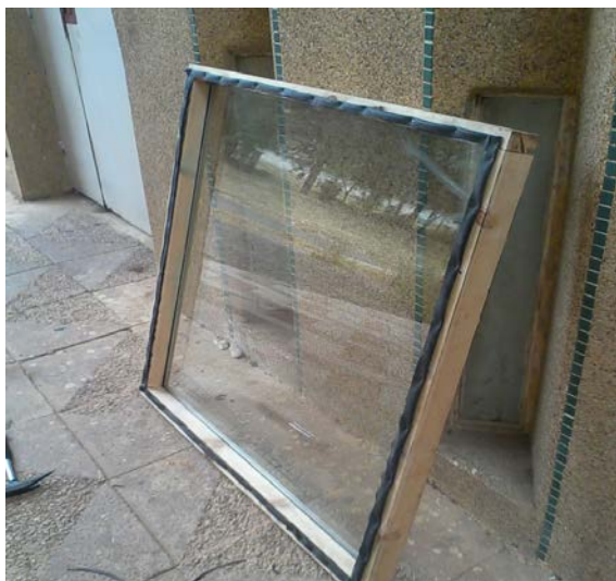
Photo 3.18:cadre en bois+ double vitrage.
