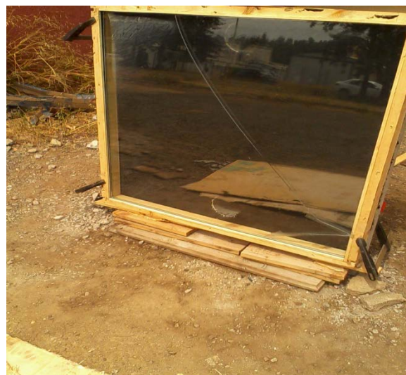
Photo 3.19:assemblage le cadre et le mur
