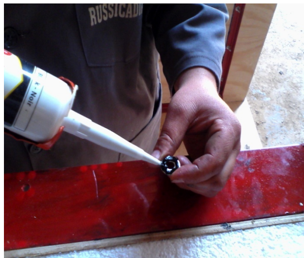
Photo3.23: isolation par silicone.
