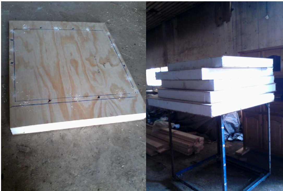
Photo 3-9: Panneau contreplaqué+ polystyrène Photo3-10: Parois de la chambre
