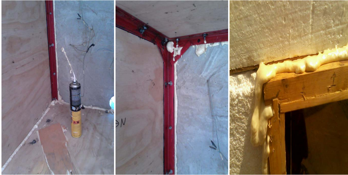
Photo3.22: isolation par mousse polyuréthane.
