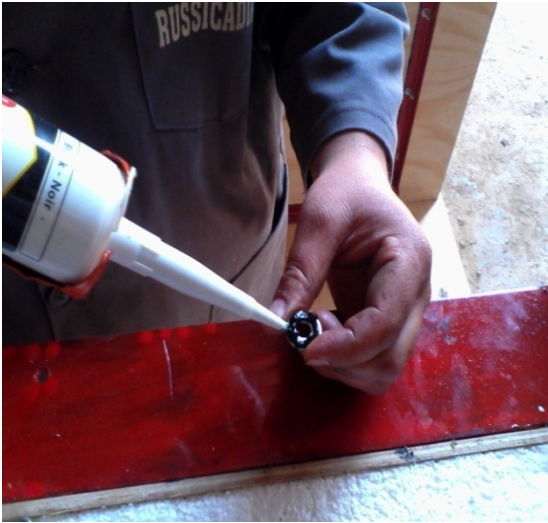
Photo3-11: Isolation des rondelles
