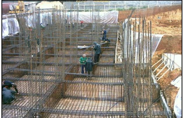
Figure 06 : Fondation en radier en travaux.
