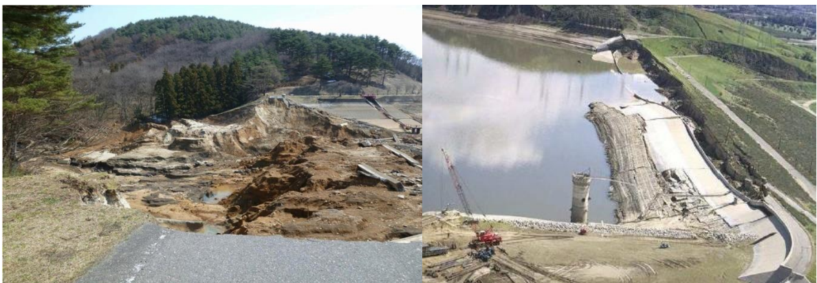
Figure 1.6 : a) Rupture du barrage du Fujinuma lors du séisme de Tohoku (2011).
