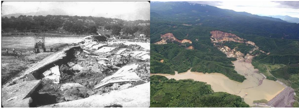
Figure 1.7: rupture du barrage de Sheffield (1925) et le barrage d'Aratozawa (2008) par glissement
