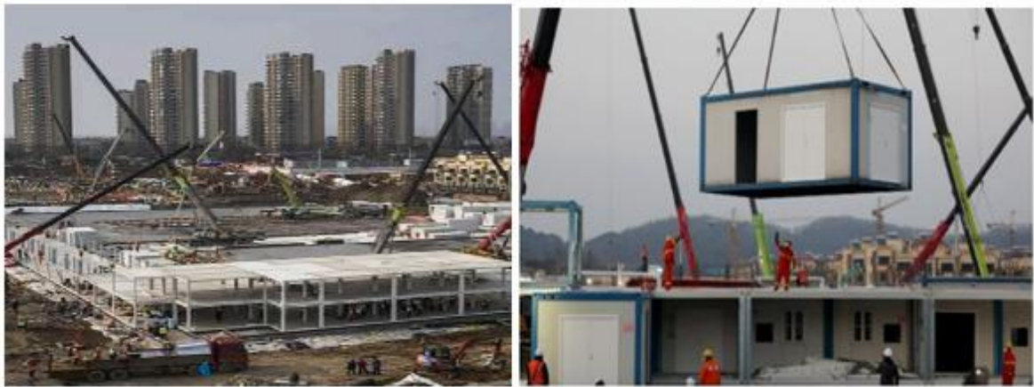
(b) Construction module en site [41].
