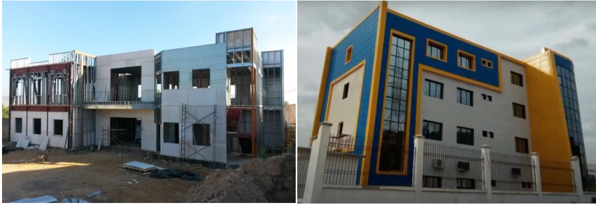
(a) Batiments d'ONAAPH, Chlef [35]. (b) Construction de NAFTAL, Skikda [35].
