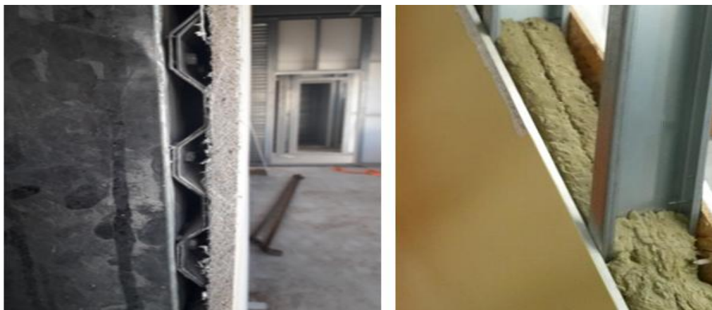
Figure 1.16 : Système de protection d'un panneau PLF.
