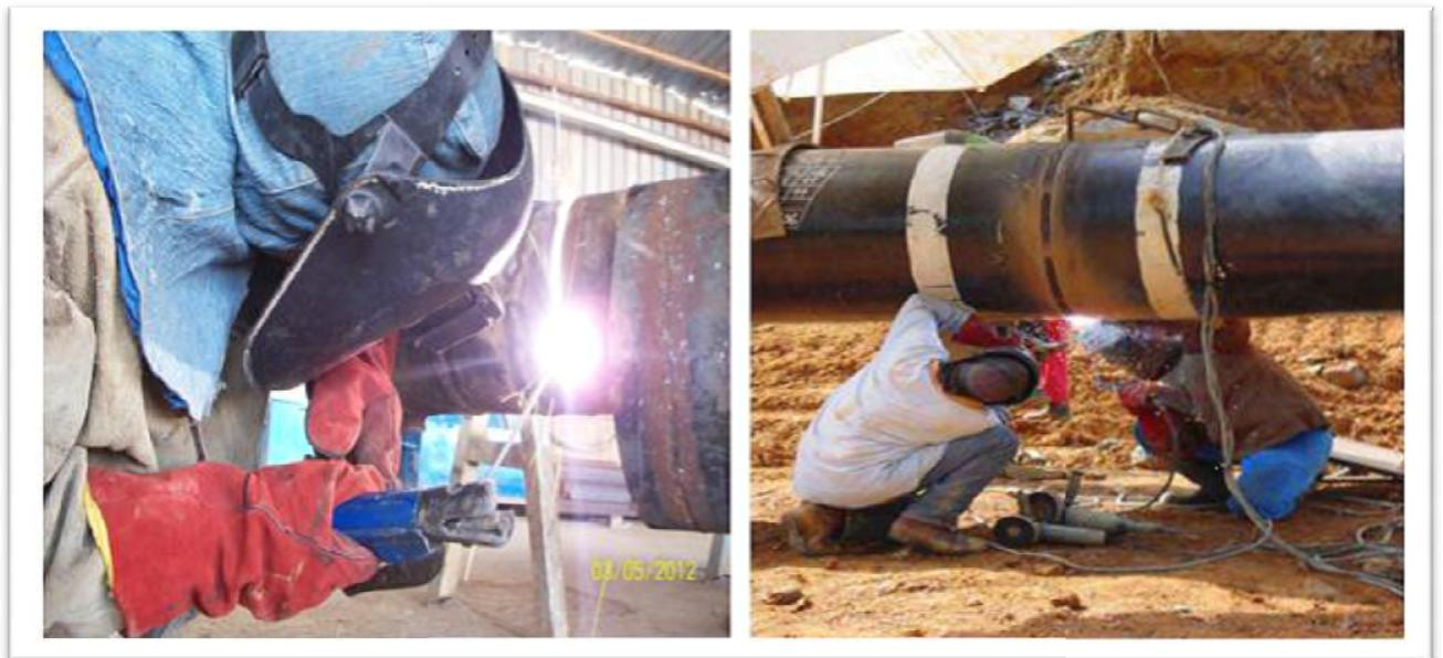
Figure I.4 : Soudage des pipelines (type manuel).
