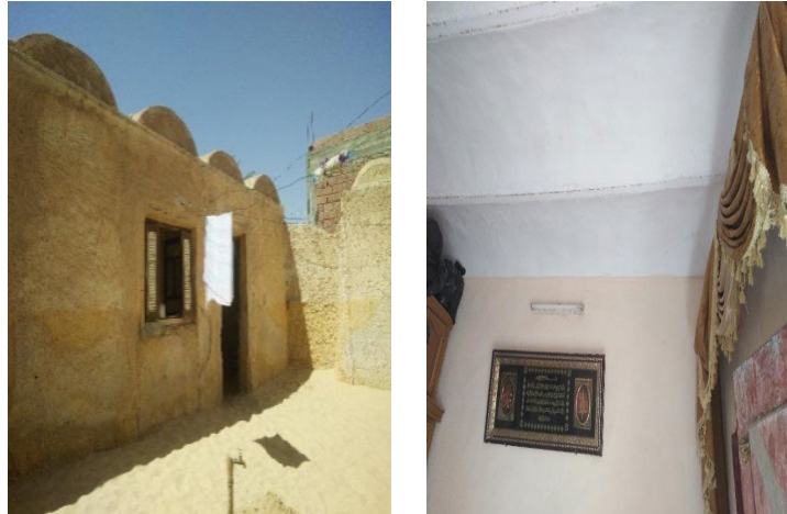
Figure.23 : toiture en voute, auteur.
