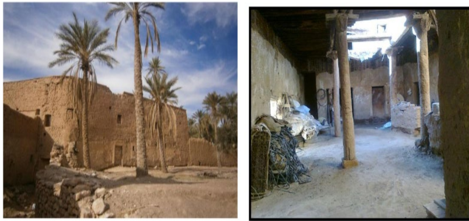
Figure.18 : Habitation oasienne à Chetma (Biskra), structure en palmier 57
