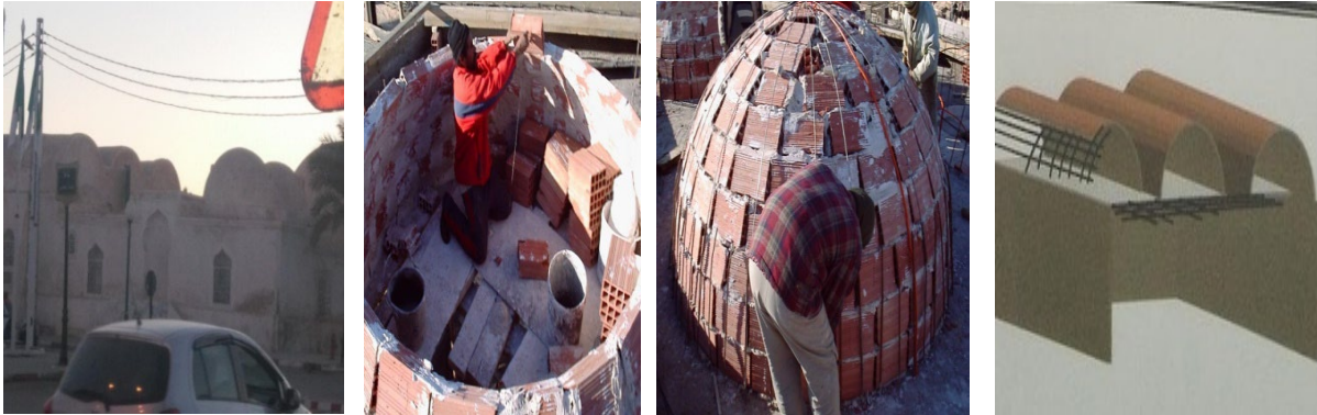
Figure.36 : Toiture en coupole pour logement contemporain, auteur.
