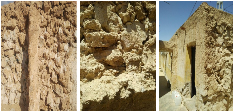
Figure.33 : mur massif en pierre de lous, Auteur 2018.
