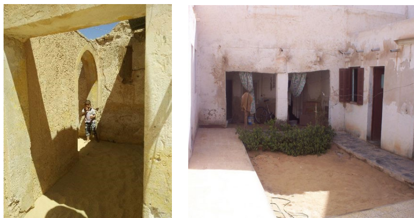
Figure.23 : traitement de sol avec du sable. Auteur.
