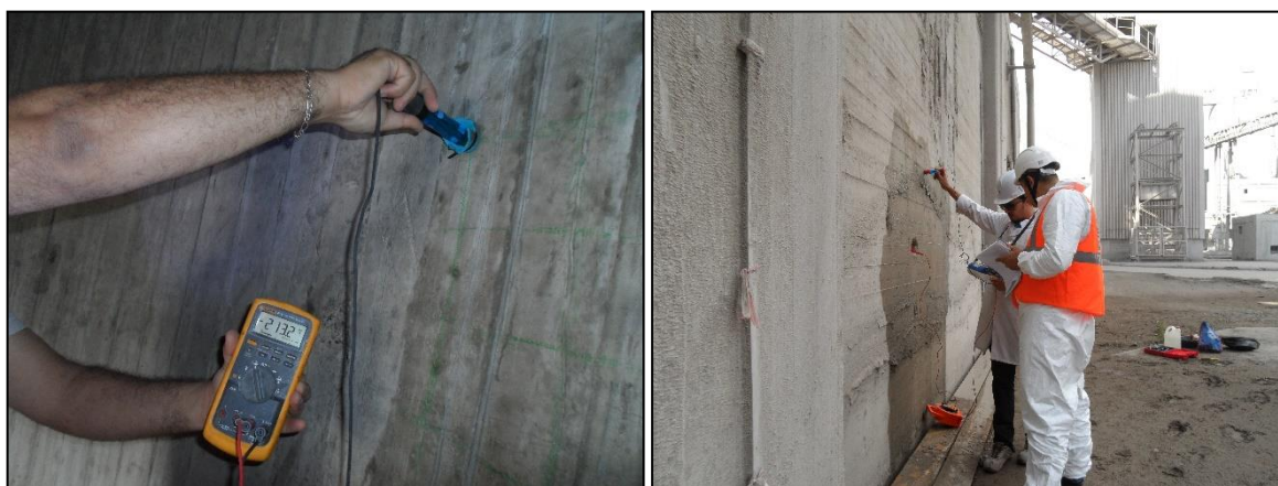
Figure 4. 12 : Mesure du potentiel de corrosion.
