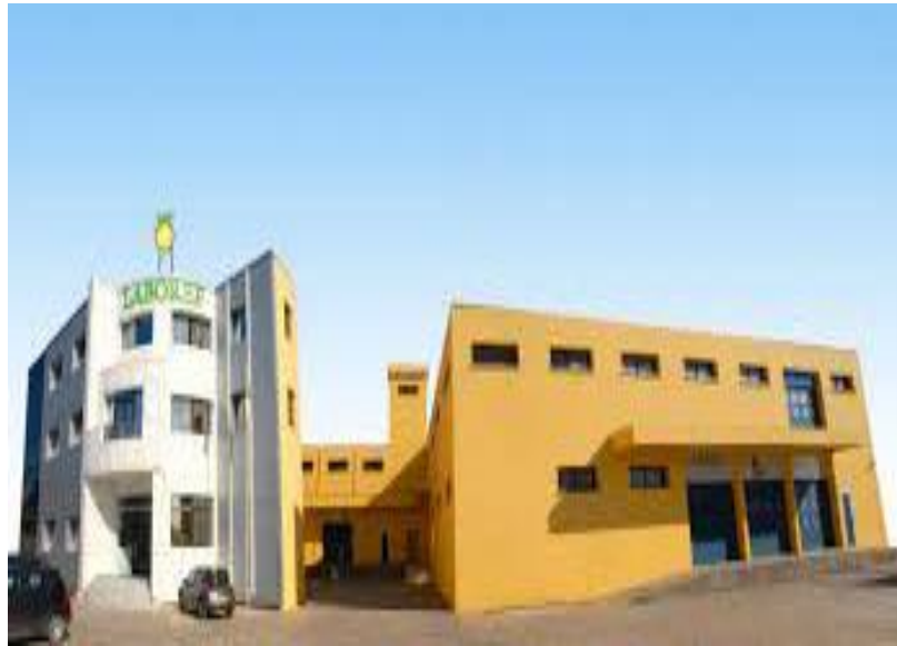
Figure 2.2. Vue d'ensemble de l'usine.
