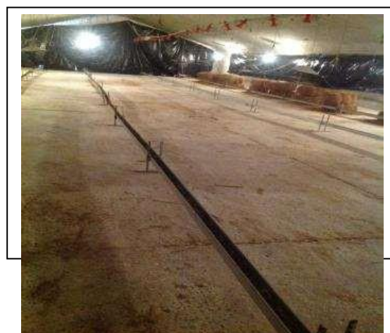
Figure 08 : Préparation du bâtiment(Photo personnelle)
