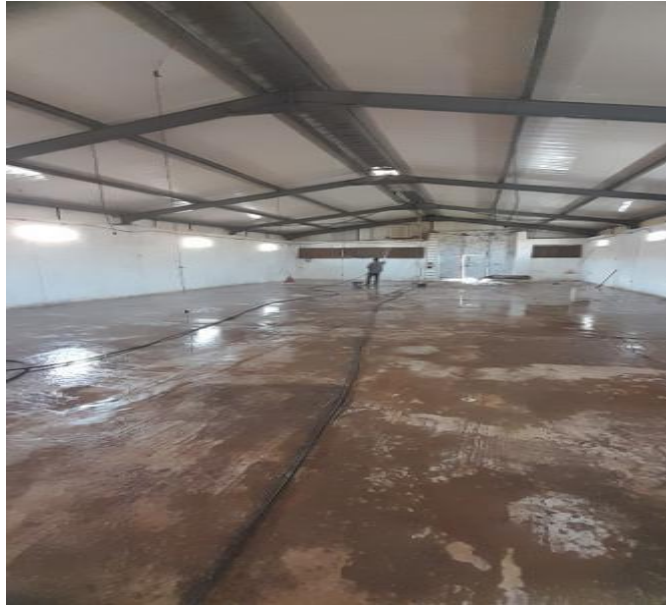
Figure 30 : Lavage et Désinfection du bâtiment
