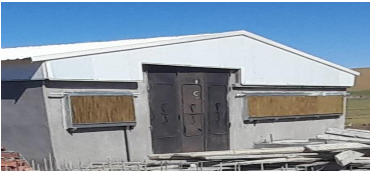
Figure 25 : Les pad-cooling (vue externe)
