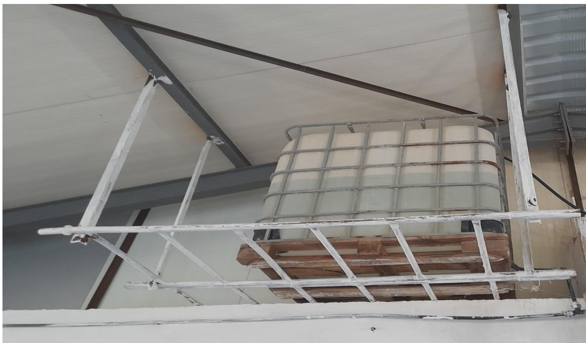
Figure 20 : Réservoir en plastique de 1000 litres.
