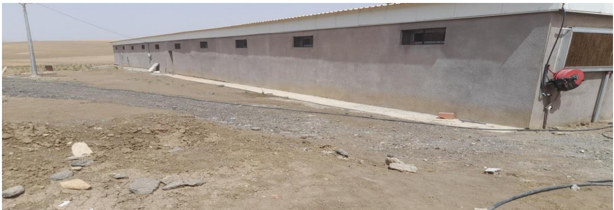
Figure 16 : Vue extérieure du bâtiment d'élevage (photo personnelle. 2023)
