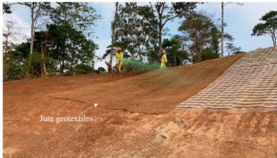
Figure 2. 9: Utilisation de géotextiles de jute pour le contrôle de l'érosion et la stabilisation des pentes (projet pratique réalisé au Vietnam, 2022-2023, photo fournie par FUCON).
