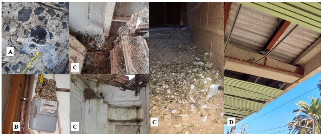
**Figure 3.54 :** Dégradation des immeubles à cause des fientes des pigeons (A- L'acidité des déjections des pigeons ; B- Dans un bâtiment ; C- Détérioration des maisons ; D- Dégradation des gares).
