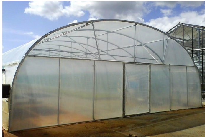
Fig. (II.3) : Serre tunnel
