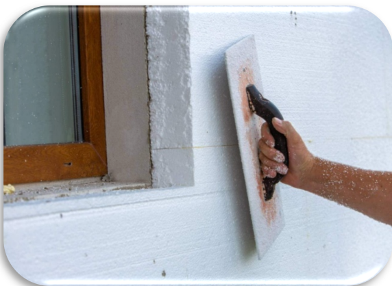
Figure 4-2: Finition de l'isolation avec l'enduit [5].
