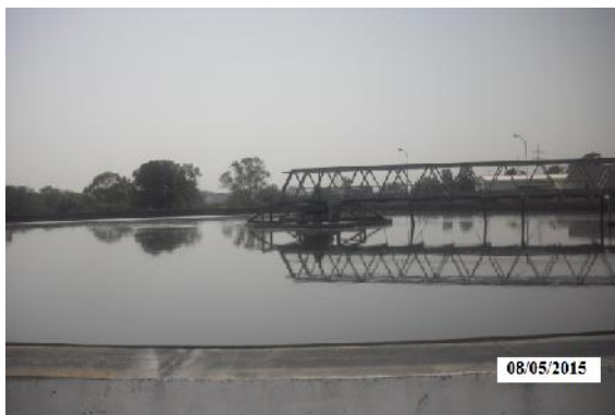
Décanteur primaire de la STEP de Reghaia ( photo originale )
