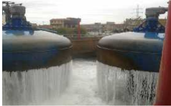
Figure 5 : obturateur à disque(photo originale, 2015)
