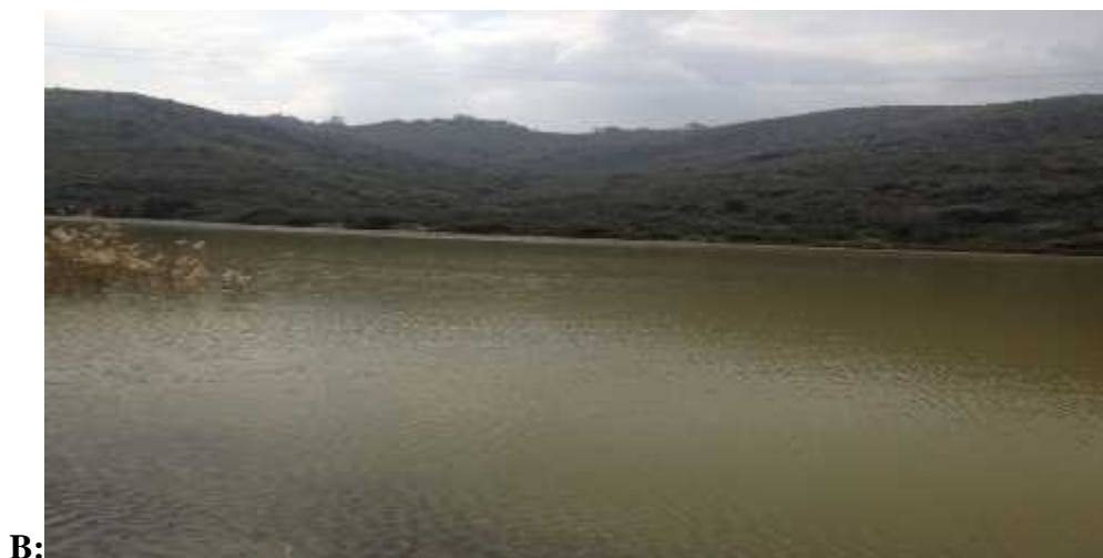
Figure 4 : barrage de KEDDARA
