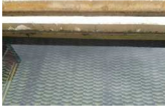
Figure 7 : les modules lamellaires du décanteur(photo originale, 2015)
