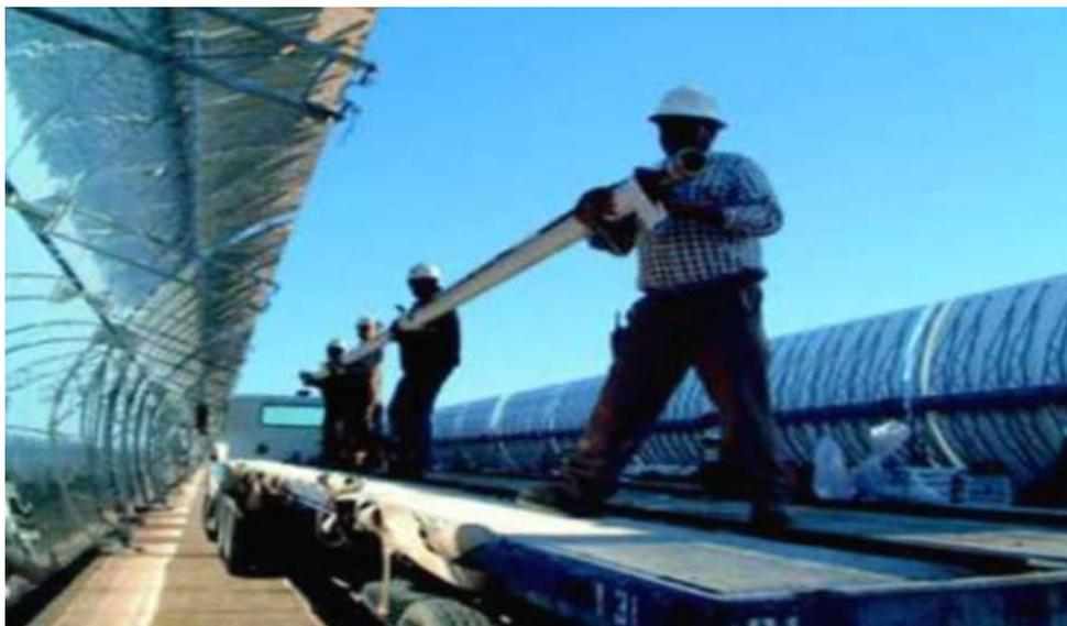
Figure I.19 : Montage d'un élément de récepteur tubulaire sur un capteur cylindro-paraboliques.
