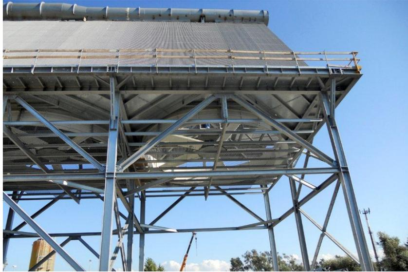
Figure III.11 : Condenseur à air à circulation forcée.
