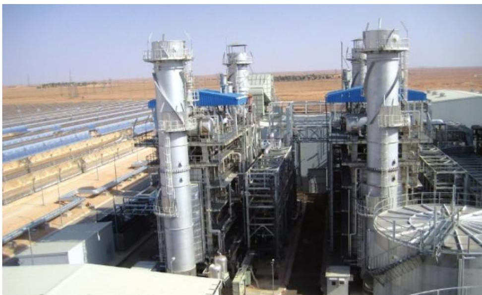
*Figure I.1 : Centrale hybride solaire-gaz hassi R'mel.*
