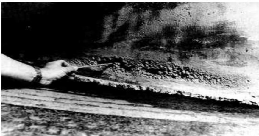
Figure 2-9 : Détérioration des pièces mécaniques soumises à une exposition prolongée à la cavitation.
