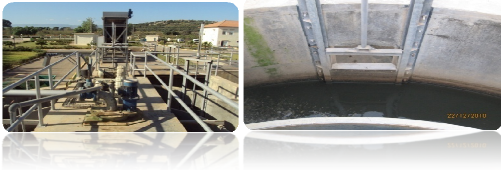
Figure N°35. Dessableur / Dégraisseur
