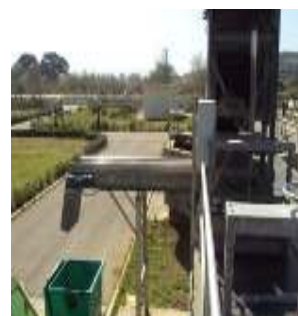
Figure N°34. Poste de rejet
