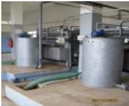
Figure N°41. Sal de Déshydratation des boues par filtre à bande
