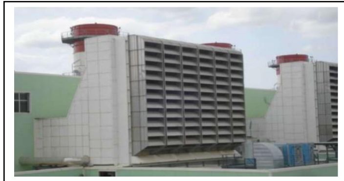
Figure1.7 Système d'admission d'air.
