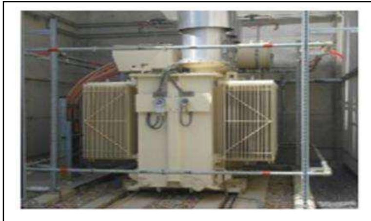
Figure 1.11 Transformateur auxiliaire.
