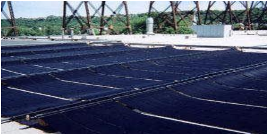
Figure1.2 : Capteurs solaires sans vitrage [5].
