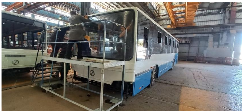
Figure III.3 : méthode actuelle de montage de par brise.
