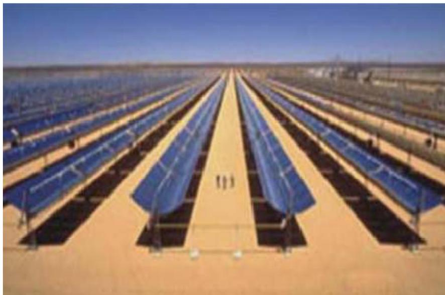
**Figure 1.14** Champ d'une centrale cylindro-parabolique [33]
