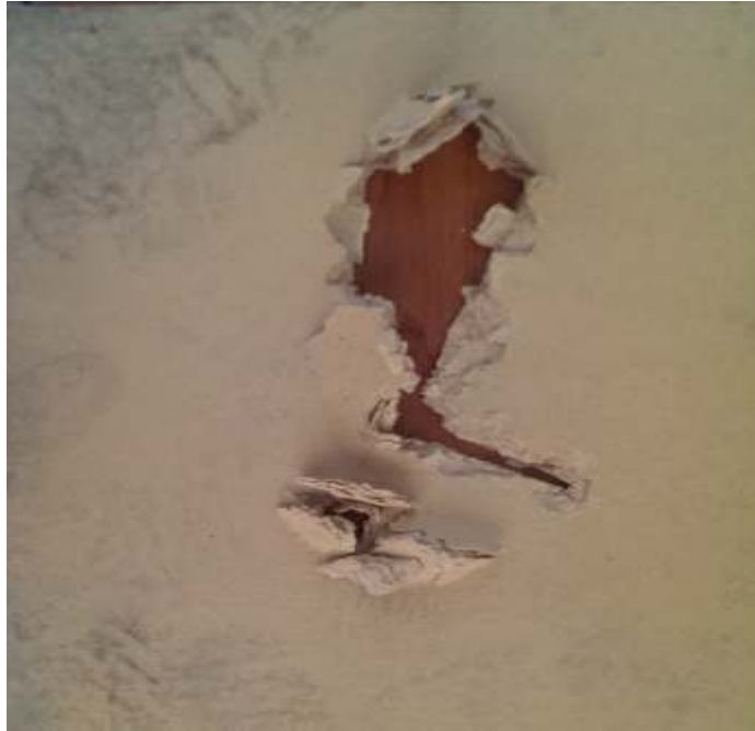
Figure 3-8 : Plaque en carton non revêtue après essai au choc.
