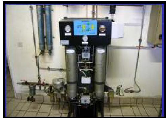
Figure 4 : La filtration d'air.
