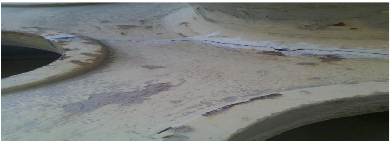
Photo 4.3 Photo Prise sur le volant d'inertie, qui montre la position de la fissure près du périmètre du moyeu, et qui traverse l'épaisseur total du volant d'inertie.
