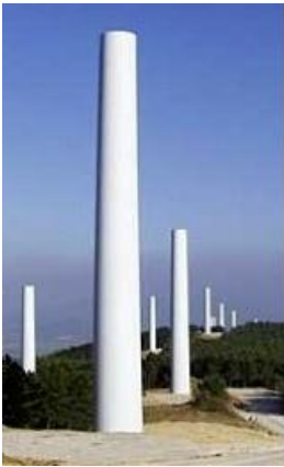
Mât en béton
