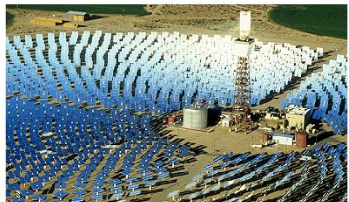
Figure 5 Tour solaire à concentration [10]
