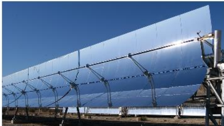
Figure 2 Schéma et une photo d'un concentrateur cylindro-parabolique[7]
