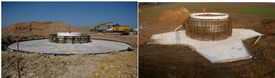
*Figure (I.20).* La fondation en béton
