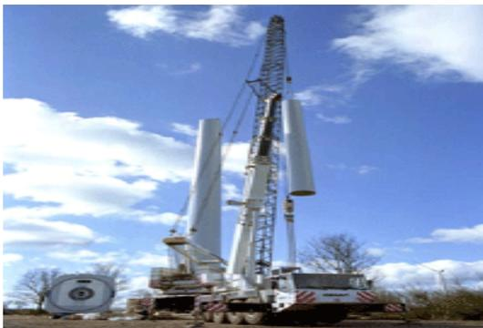
**Figure (I.8).** Montage d'un mât tubulaire
