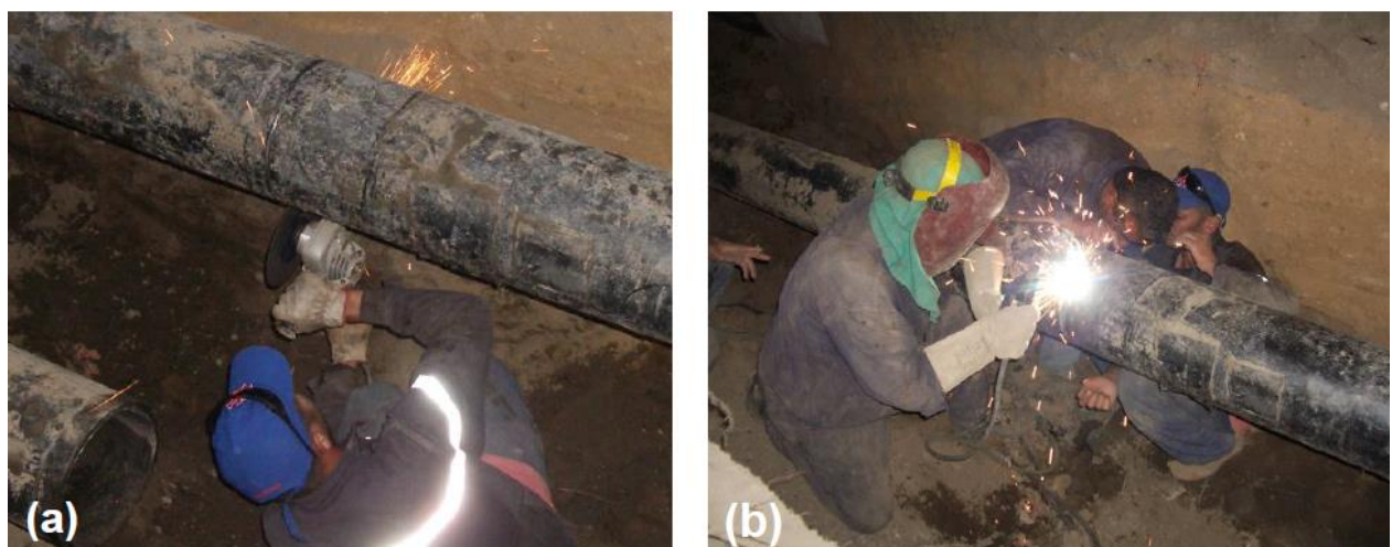
Figure 1.7 : Changement du tronçon endommagé d'une canalisation, (a) découpage, (b) ré-soudage [7]
