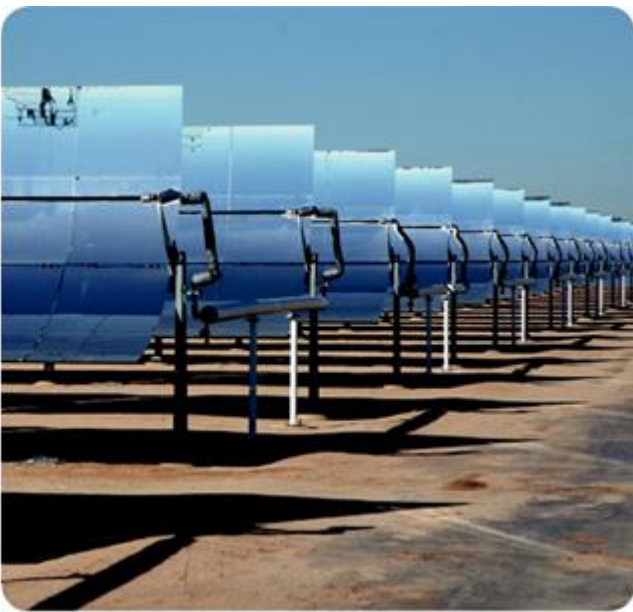
Figure 1.17 Image d'un concentrateur cylindro parabolique
