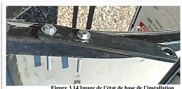
Figure 3.15 image de la fixation pour la partie mobile
