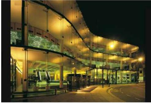
Figure 8. 7 Bâtiment composé d'une grille de piliers en béton, espacés de 14 m, supportant des planchers en dalles de béton en porte-à-faux. L'extérieur est revêtu d'un mur-rideau en verre fumé foncé.
