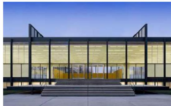
Figure 8.2 Bâtiment avec une structure à ossature d'acier. Les parois en verre sont entièrement non structurelles.
