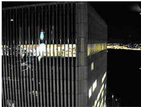
Figure 3.30 Sur cette photo du sommet d'une des tours du World Trade Center la façade traversée de colonnes est bien visible. On comprend alors en quoi elles surplombent la paroi.
