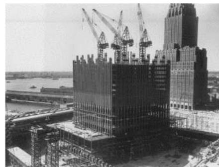
Figure 3.28 Structure en tube du World Trade center
