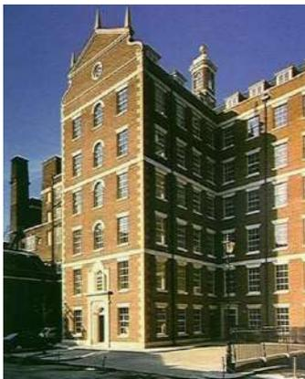
Figure 8.1 Bâtiment dont les murs extérieurs sont les éléments porteurs.
