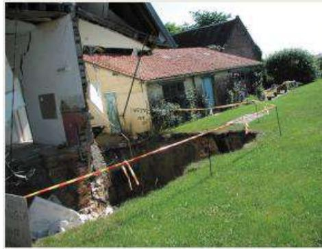
Figure 1.2 Effondrement d'une cavité souterraine en zone urbaine au niveau d'une habitation.
