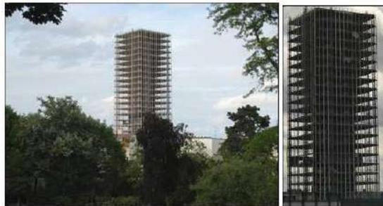
Figure 3.17 Exemple d'un bâtiment a noyau central
