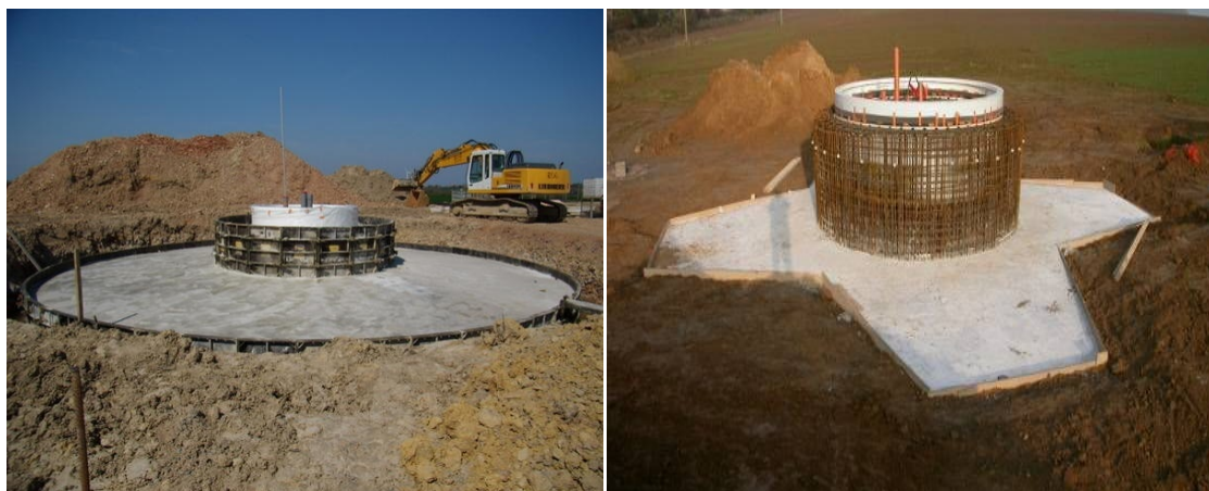
Figure 1.18. La fondation en béton.
