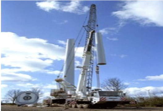
Figure 1.6. Montage d'un mât tubulaire.
