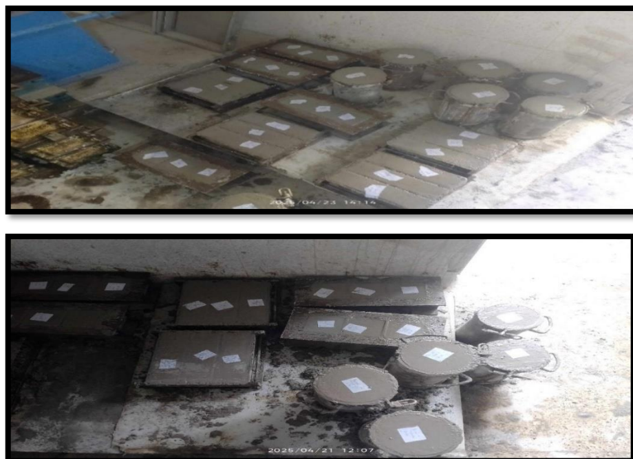
Figure II. 48: Remplissage des moules pour la réalisation des éprouvettes en béton.
