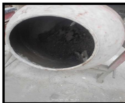
Figure II. 42: Mise en œuvre du béton dans le malaxeur
