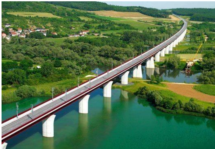
Figure I. 7 Viaduc traversant un barrage
