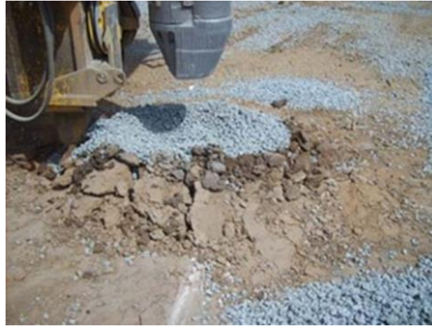
Figure 1.10 : Une colonne de ballast après la finition.[6]
