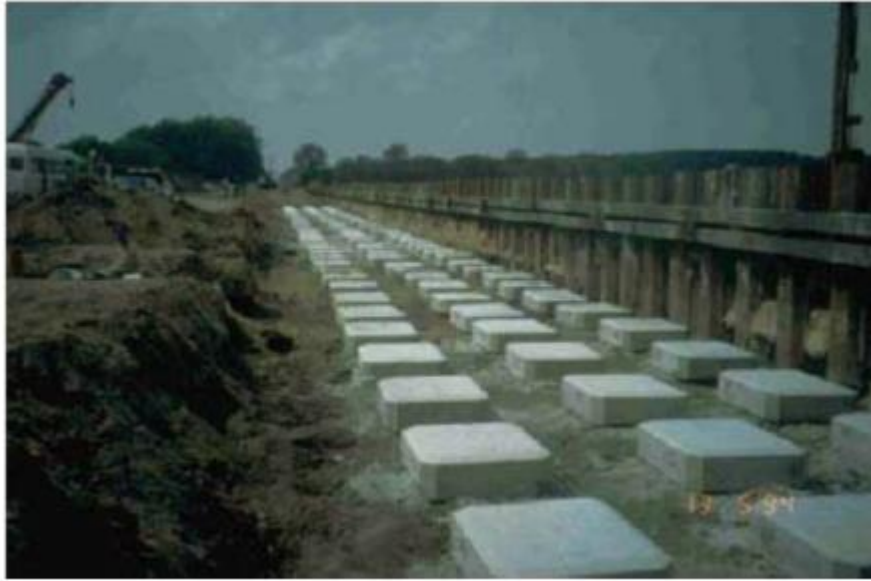
Figure 1.25 : Chantier de remblai ferroviaire, visualisation des têtes d'inclusion avant l'édification du remblai.
