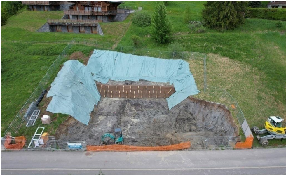
Figure I.1 : Excavation à ciel ouvert en pente.
