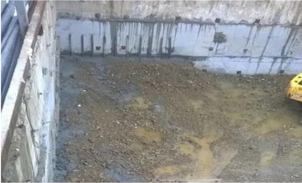
Figure I.2 : Excavation à ciel ouvert en porte-à-faux.
