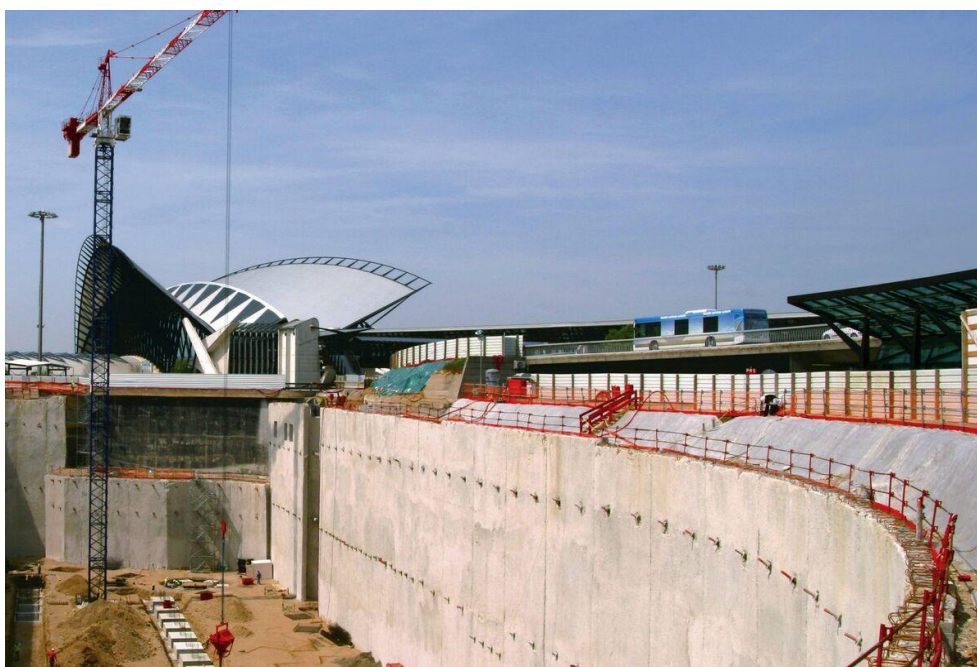
Figure I.9 : Paroi moulée, une technique de soutènement.
