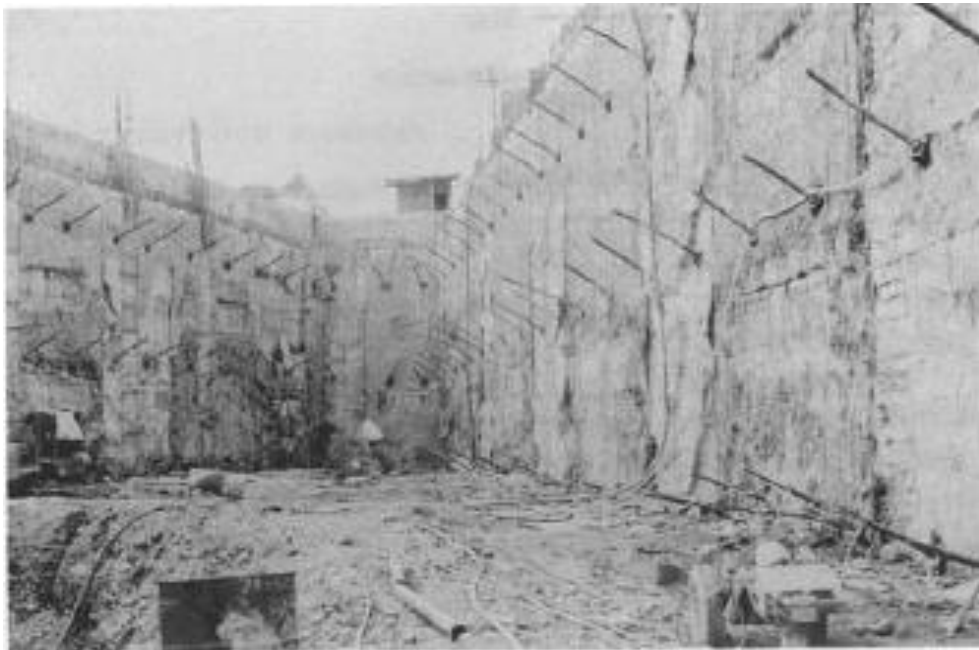
Figure I.5 : Excavation ancrée.
