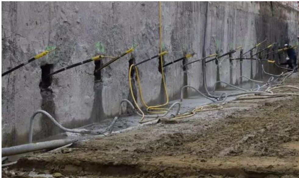
Figure I.12 : Installation des tirants d'ancrage.
