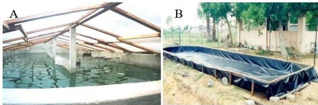
Figure 05 : A : bassin en parpaing revêtu en plastique, B : bassin en bâche plastique [20]
