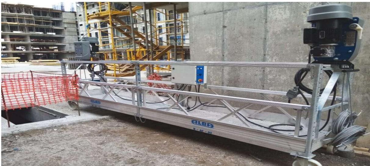
Figure 17 : Echafaudage suspendu électrique
