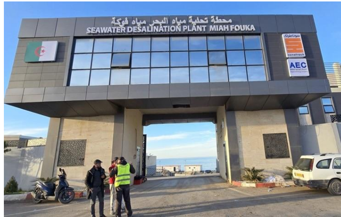
Figure 1.2: La Station de Dessalement de Fouka 2
