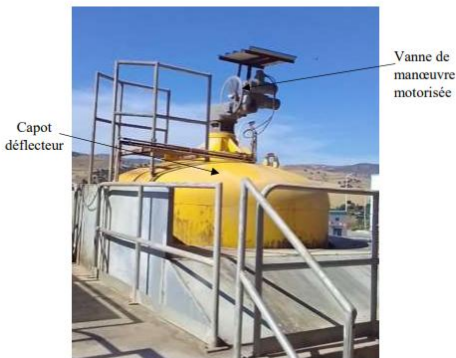
Figure 2.12: Robinet à disque auto-centreur sous capot
