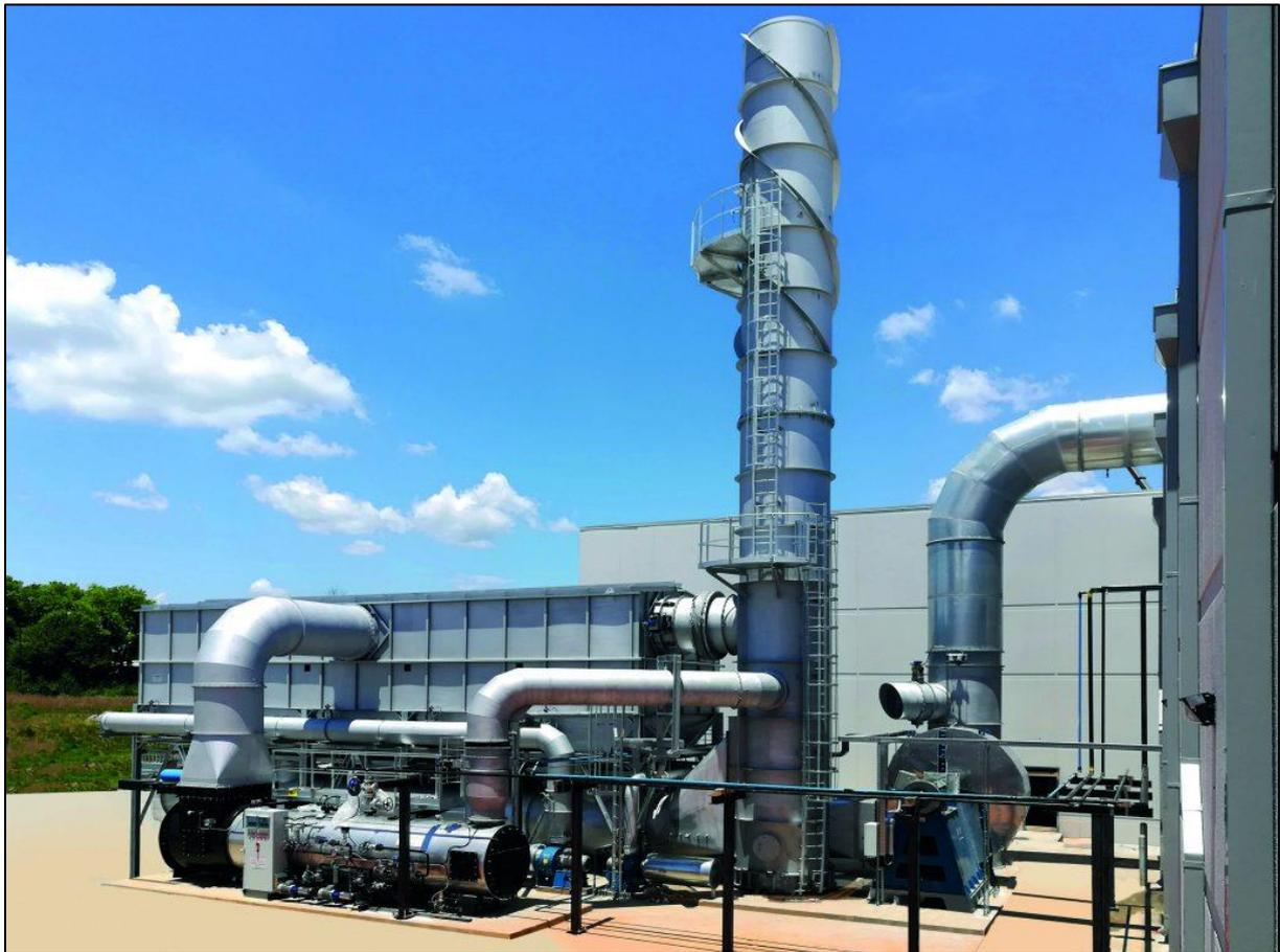
Figure II.10: La chaudière de récupération de chaleur HRSG
